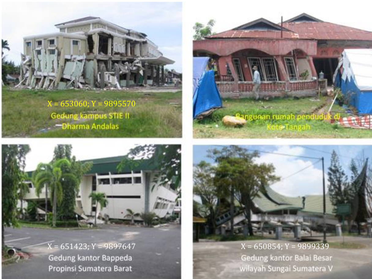
Gambar 1. Contoh kerusakan bangunan di Kota Padang akibat fenomena amplifikasi getaran gempa bumi 30 September 2009.
