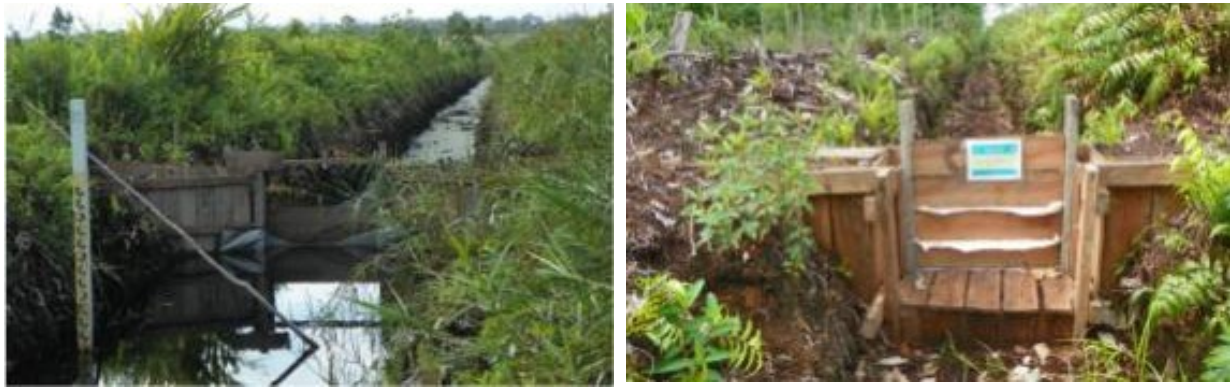
Gambar 5. Pemasangan pintu air
