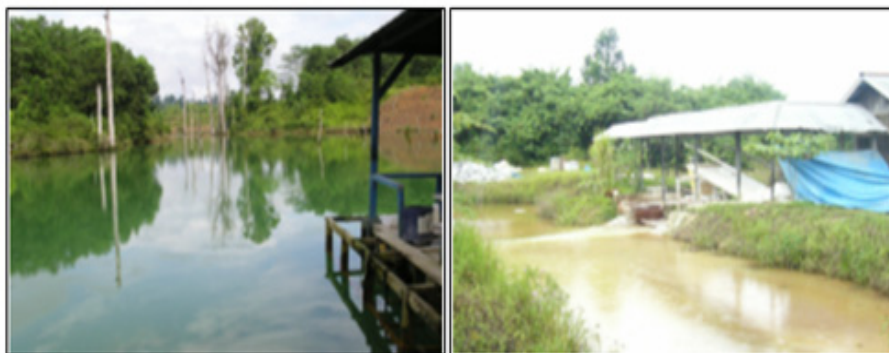
Gambar 3a. Settling Pond WMP 7, Lati. Gambar 3b. Outlet Pengolahan Aktif (CaOH).
