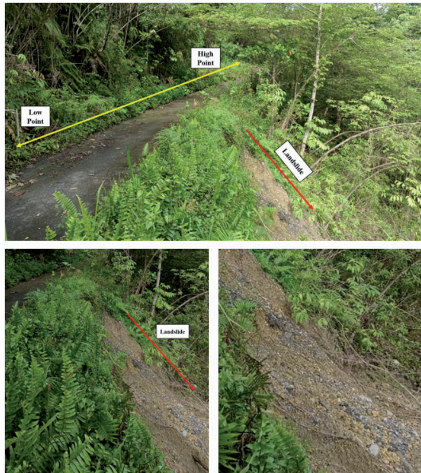
Figure 18. Rock layer on Line 4 (landslide area point B).
